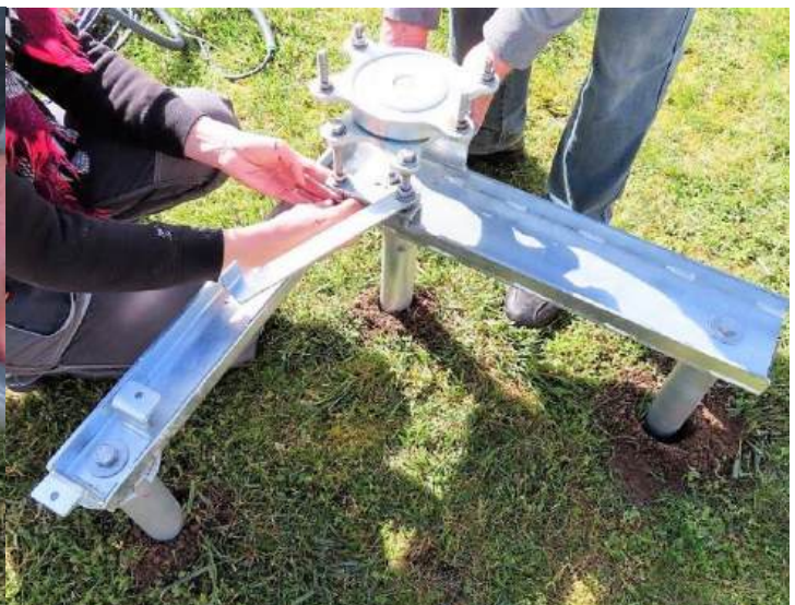
Installation du plateau pivotant.
