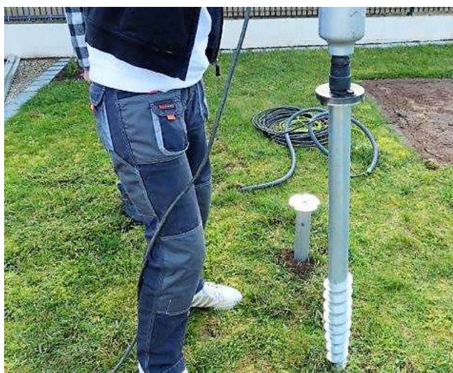
Pose des vis de fondation.
