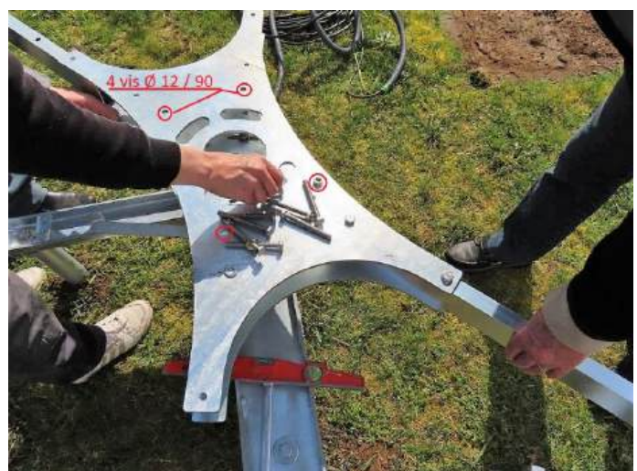
Fixation des barres support de structure. Ne pas bloquer les écrous, ils seront serrés le montage terminé.
