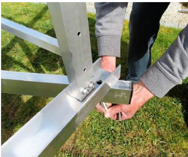
Fixation de la structure support de panneaux avec 4 vis 16x40 rondelles et écrous.
