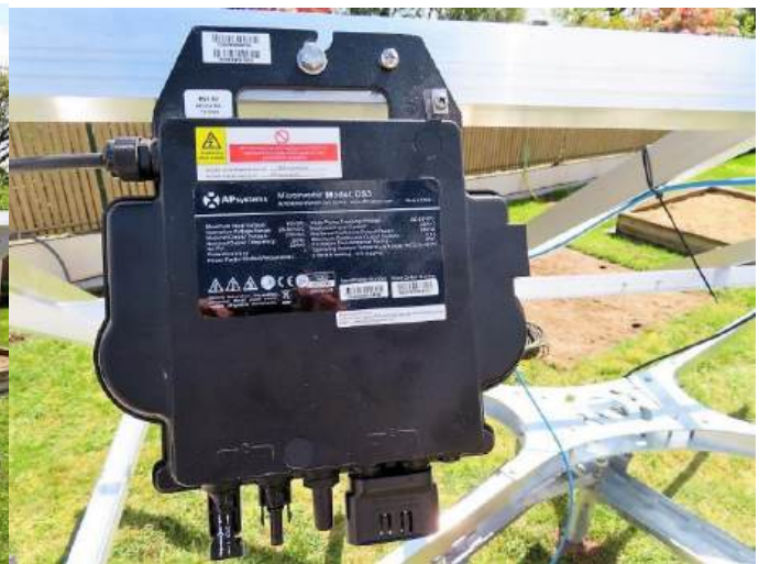
Fixation et câblage des 2 micro-onduleurs.
