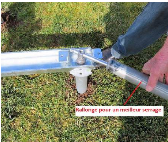
Fixation de la platine « sol ».
