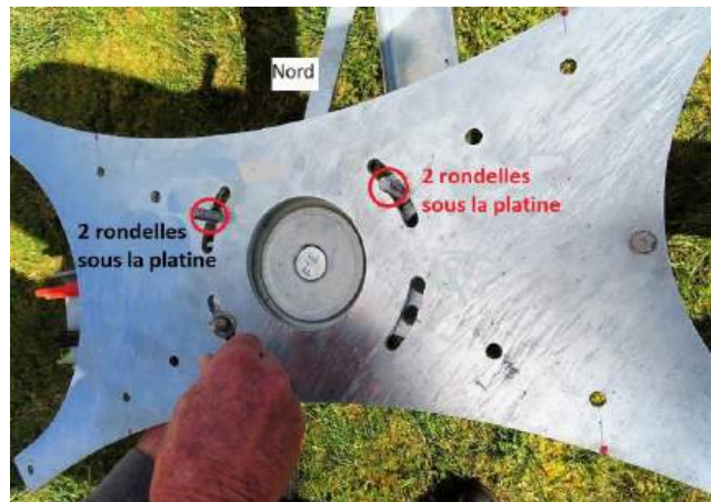
Mise en place platine inférieure (attention aux rondelles).
