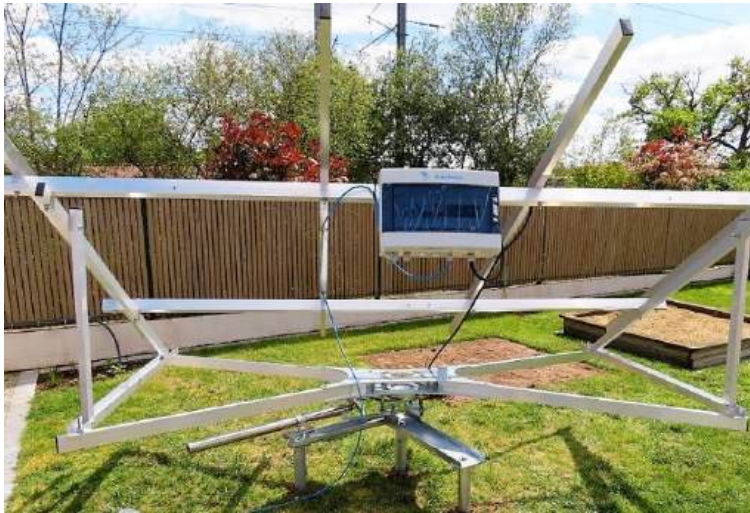
Fixation et câblage du coffret électronique.
