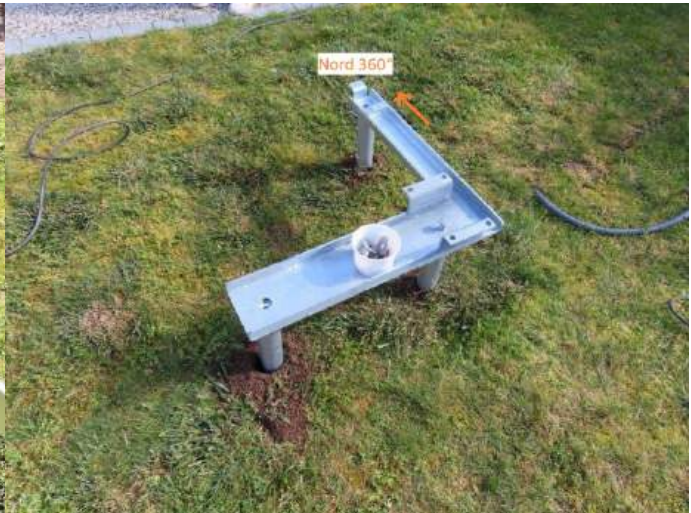
Positionnement de la platine sur les vis de fondation
