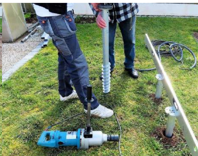
Mise à niveau des vis de fondation.
