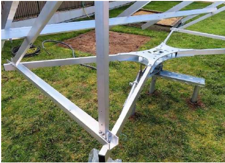
Moteur en place.
