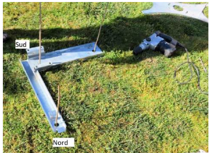
Préparation, attention bien respecter la position de la platine : partie support moteur au nord.
