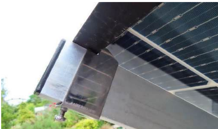
Fixation des panneaux photovoltaïques avec les griffes fournies.
