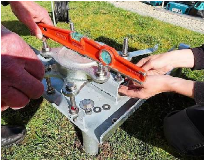
Mise à niveau du plateau pivotant, une fois de niveau serrez fortement
