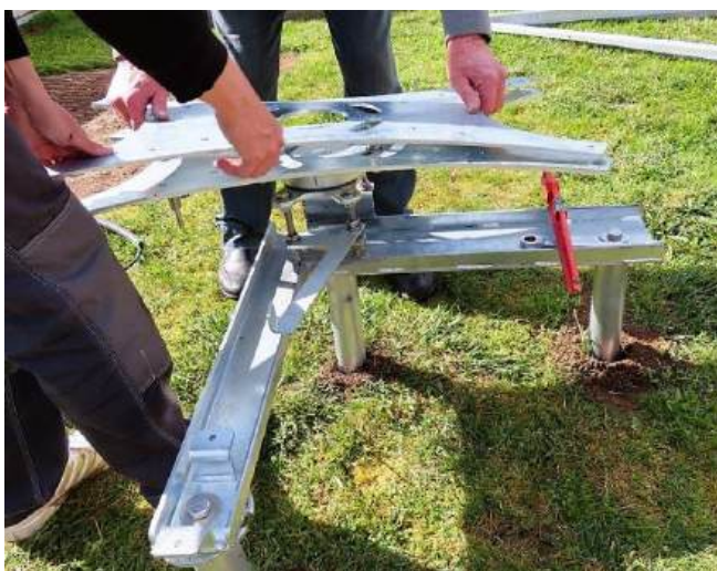
Mise en place de la platine supérieure.
