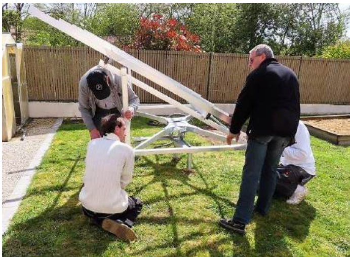
Mise en place de la structure support de panneaux.
