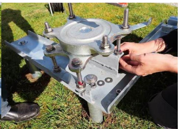
Installation du plateau pivotant.
