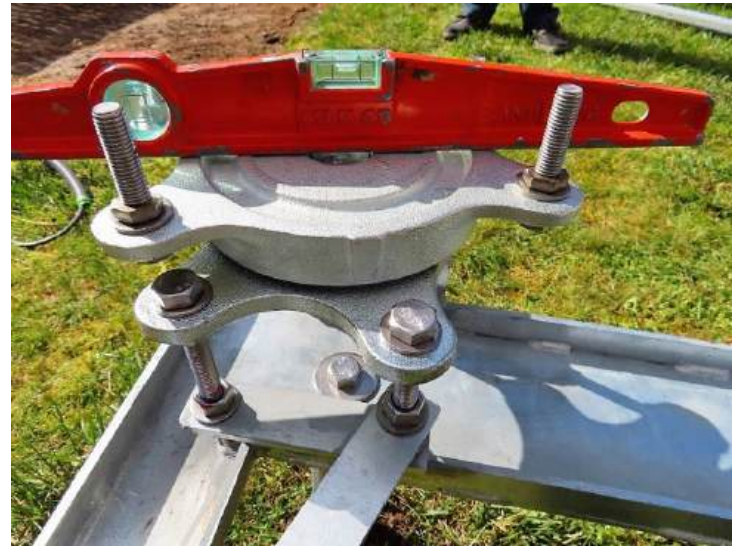
Mise à niveau du plateau pivotant, une fois de niveau serrez fortement
