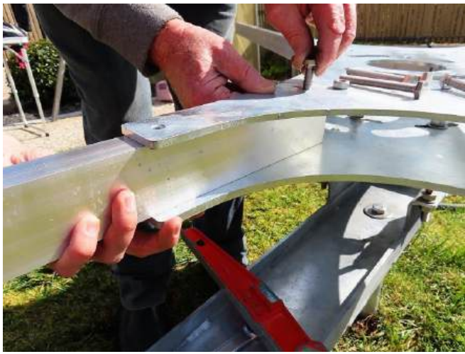
Fixation des barres support de structure. Ne pas bloquer les écrous.
