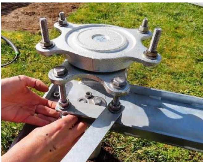
Fixation du plateau pivotant.
